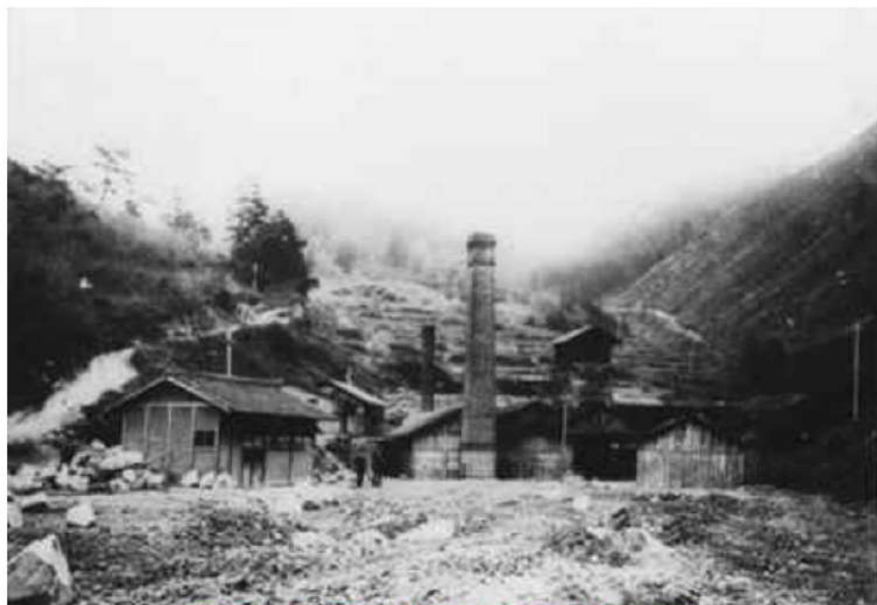
写真-1 琵琶湖疏水第1竖坑付近
