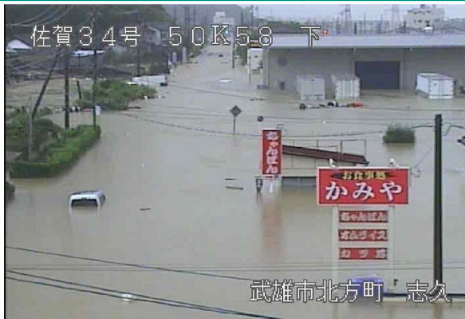
▲令和3年8月の大雨の被害の様子 (佐賀県武雄市 六角川周辺) (写真提供：国土交通省 九州地方整備局)
