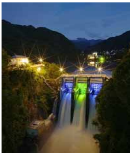
高遠さくら発電所 (伊那市)
