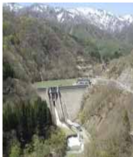
水芭蕉発電所 (長野市)
