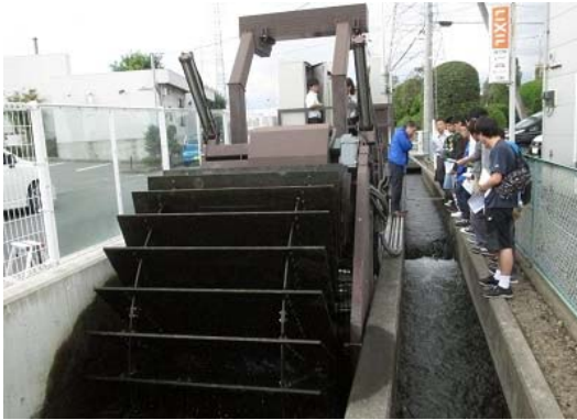
小水力発電施設「ニコニコ水力１号」 (静岡県長泉町)
