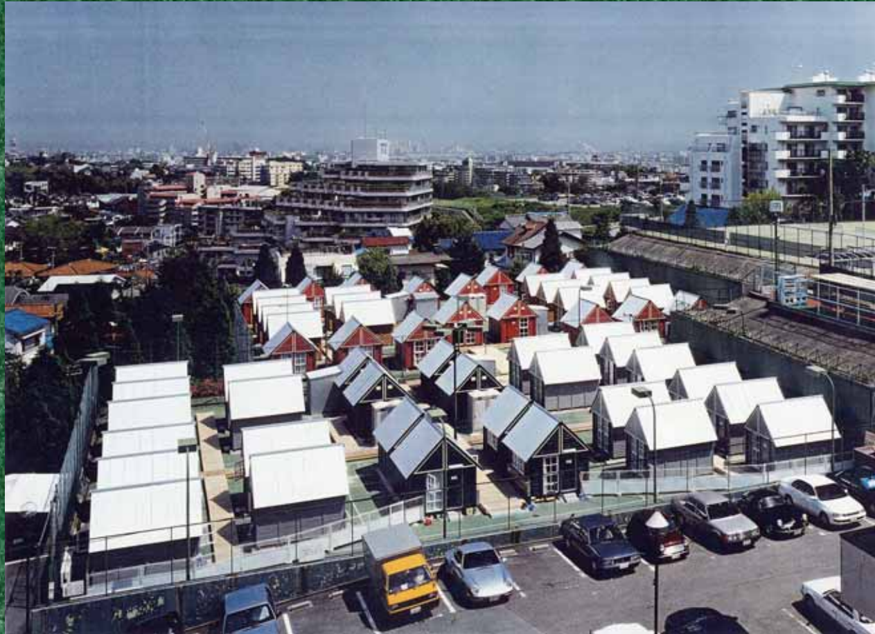
阪神淡路大震災の際の仮設学生寮の建設
