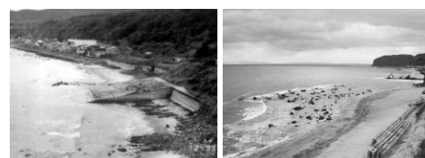
木野部海岸の緩傾斜護岸。再生事業前（左）と事業後（右）
