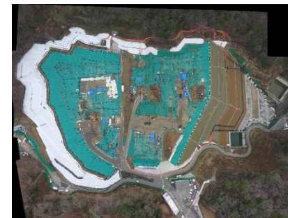
特定廃棄物埋立処分施設の様子
