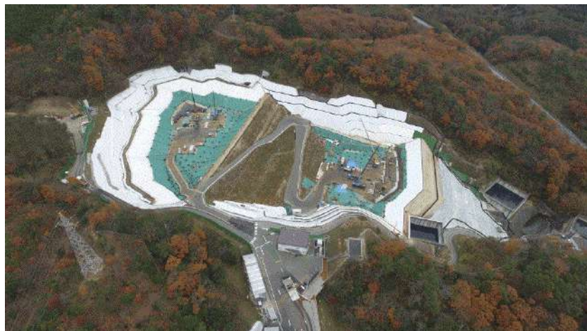
管理型処分場の様子
