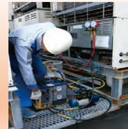
フロンガス回収 (環境省HPより)
