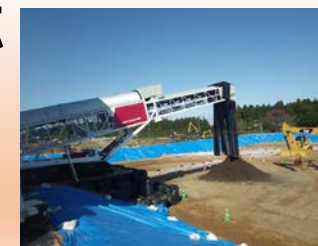
中間貯蔵施設 土壌貯蔵施設
