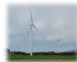
風力発電 (環境省HPより)
