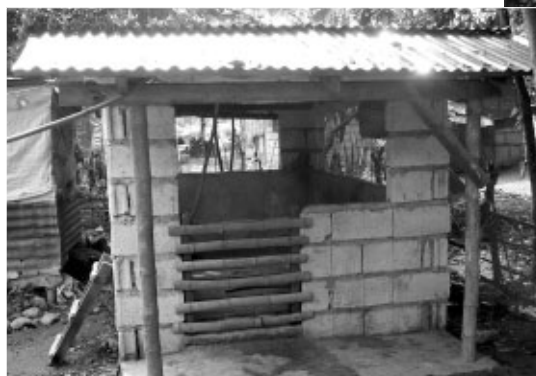
飼育用豚舎は、主にコンクリートブロックとトタン、木材で作られている。ちなみに豚は、一度の出産で、10頭程度産み落とすそうだ。
